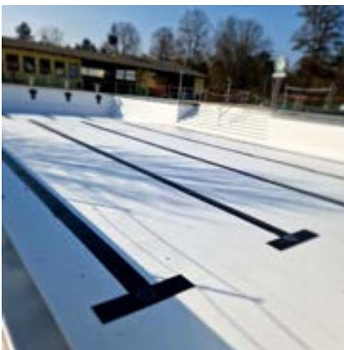
Die Beckenfolie in beiden Becken im Bädle müssen ausgetauscht werden. Die Folie besitzt eine Lebensdauer von 10 Jahren und wurde bereits 2008 eingebaut. Da nun ein Riss der Folie inklusive Beckenschließung ein drohendes Szenario war, entschloss man sich, die Folie (zunächst im Schwimmerbecken) zu tauschen. Wir bedanken uns an dieser Stelle bei den Firmen P+H Sportanlagenbau
